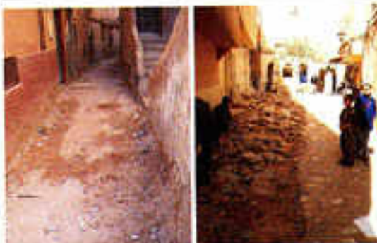
Détérioration des différents réseaux à cause du décapage total du sol
