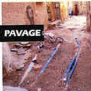
Détérioration des différents réseaux à cause du décapage total du sol
