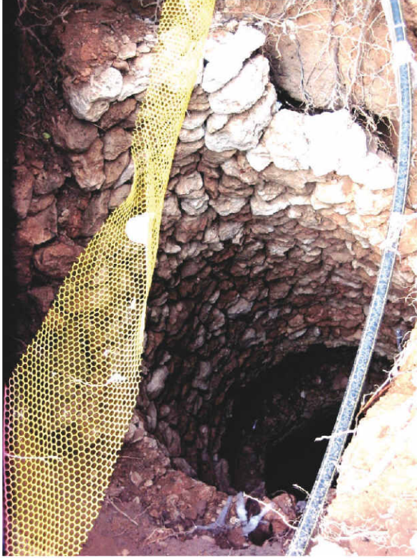
إنفصال موضعي للحجارة المكونة لجدار الربط
