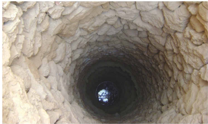
جدار الربط داخل البئر
