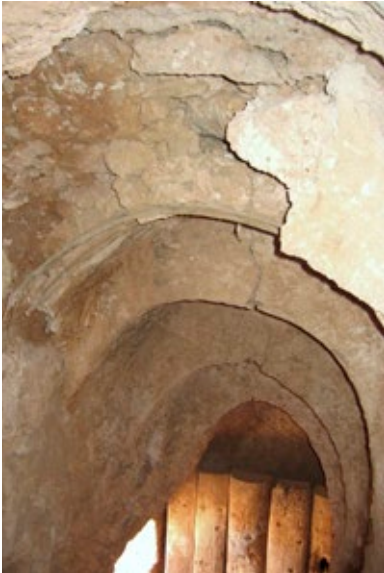
Plancher d'un escalier dans une tour
