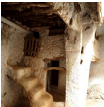
Utilisation de troncs d'arbres pour supporter l'escalier
