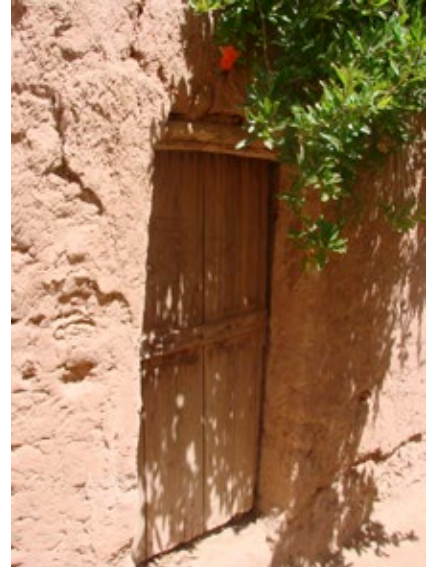
Linteau en tronc d'arbre à l'entrée d'une habitation
