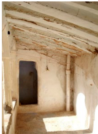
Plancher incliné d'Ikomar, construit en troncs de palmiers
