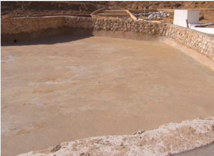
Restauration de la couche d'étanchéité d'un plancher Pose d'une couche d'argile et d'une couche de mortier de chaux
