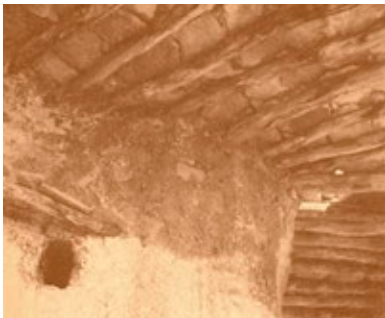
Plancher en troncs d'arbres et pierres plates Mausolée Ammi-Saïd - Ghardaïa
