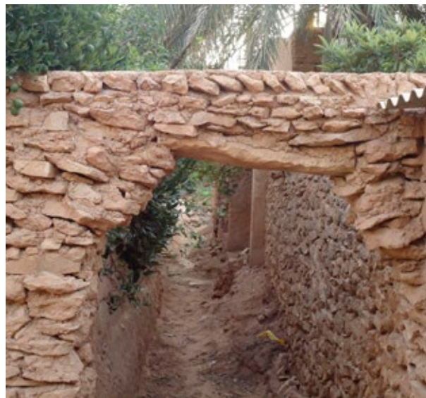
Pierre plate utilisée comme linteau sur un passage pour supporter une séguia
