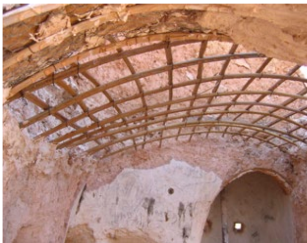
Travaux de restauration d'une voûte dans la tour Zelliga - Béni-Isguen
