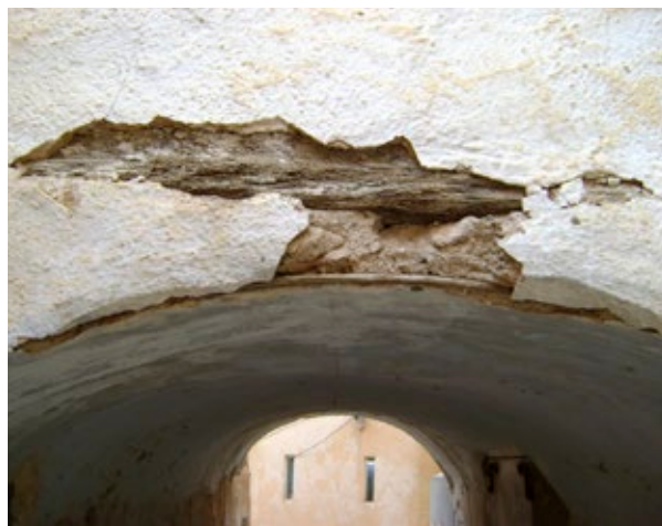
Une voûte dans le ksar, avec présence de tronc de palmier pour supporter une partie des charges et stabiliser la construction
