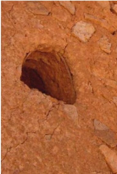
Utilisation d'arc dans une ouverture de tour
