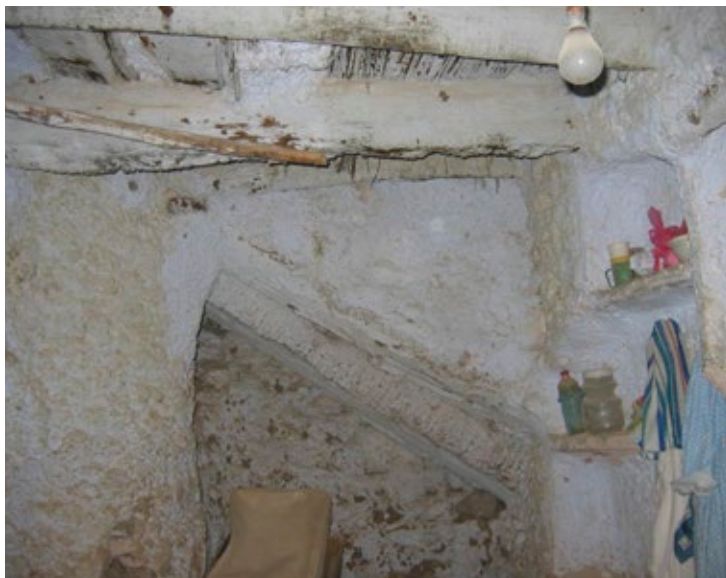
Plancher d'escalier porté sur troncs de palmiers
