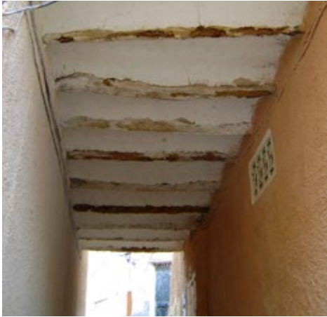
Plancher en troncs de palmiers et voûtains dans un passage couvert du ksar
