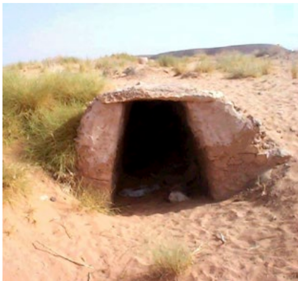
Pierre plate utilisée dans le dallage d'un canal de crue
