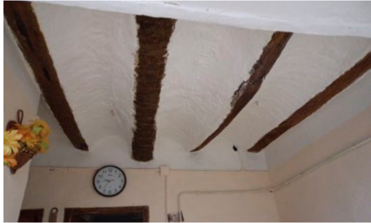
Plancher en troncs de palmiers et voûtains dans une habitation du ksar
