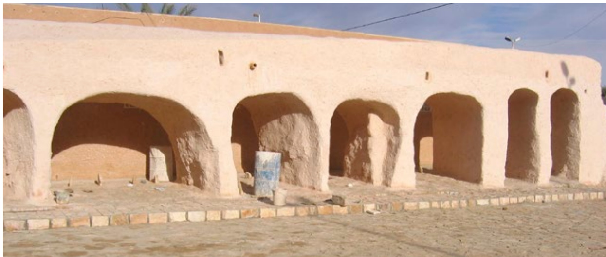
Utilisation des voûtes au diversoir de Salem-Ouaissa - Ghardaïa
