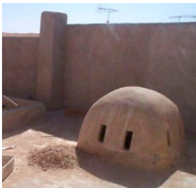
Coupole de forme carrée dans une habitation traditionnelle Vue interieure et exterieure
