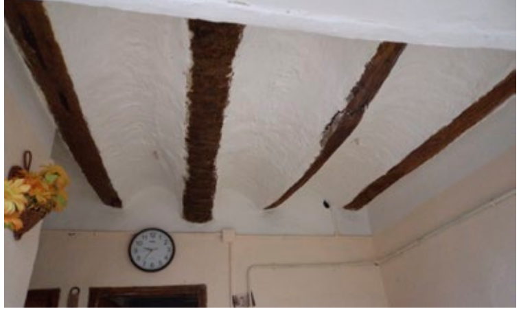
سقف من جذوع النخل وأقباة صغيرة في مسكن بالقصر
