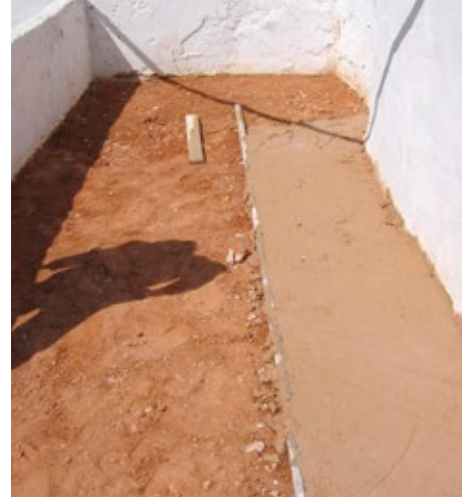
إعادة الطبقة العازلة أثناء ترميم سقف- وضع طبقة من الطين ثم ملاط الجير
