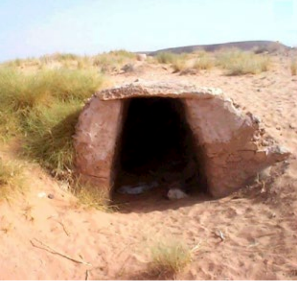
حجارة مسطحة تستعمل لتسقيف قناة مياه السيل
