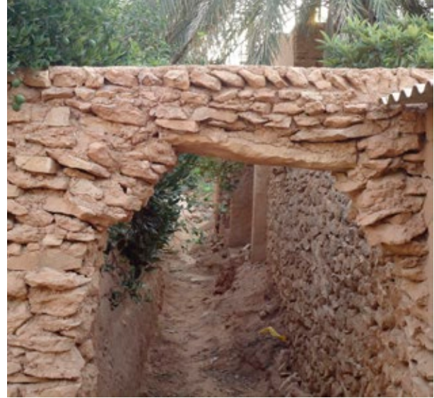
حجارة طويلة تستعمل كسكاف بممر (لحمل ساقية ماء السقي)
