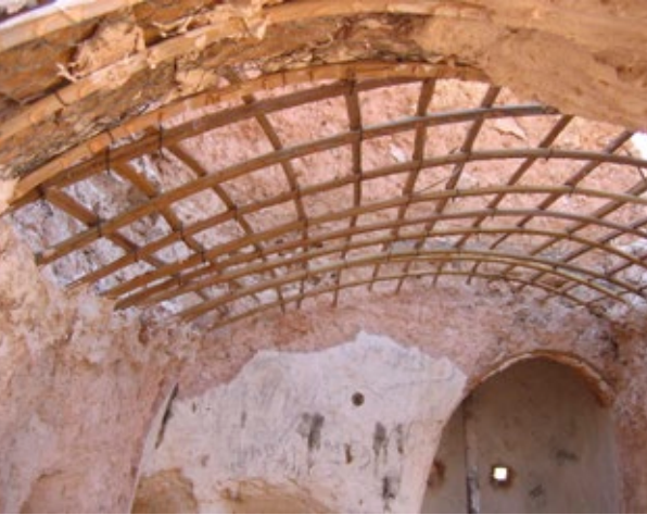
عملية لإعادة بناء وترميم قبو ببرج زليقة ببني يزقن
