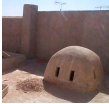
قبة مربعة الشكل بمسكن تقليدي بالقصر - منظر داخلي وخارجي
