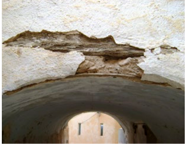
ممر مسقف داخل القصر مع وجود الجريد الذي يشد هيكل القبو وملاحظة جذع النخل فوق القبو لزيادة الربط وتحمل أجزاء من الثقل
