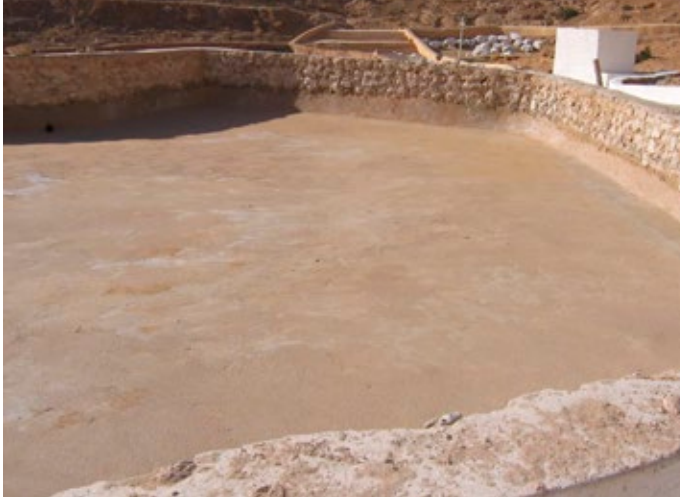
إعادة الطبقة العازلة أثناء ترميم سقف- وضع طبقة من الطين ثم ملاط الجير
