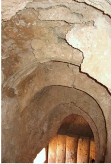
سقف درج داخل برج
