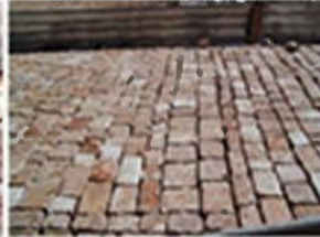
تبليط بحجارة ممددة مسطحة وأبعاد محددة Pavage avec des pierres planes multiformes
