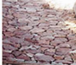
تبليط بحجارة مسطحة مختلفة الأشكال Pavage avec des pierres planes multiformes
