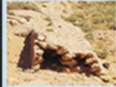
حاجز ومصب نياه السيل مشطور. بني بالحجارة وملامد الحجر - يتكون من ثلاثة جدران وسدق من الحجارة، ويعمل الفراغ بين الجدران بالترية.
