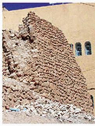
حاجز ومصب نياه السيل مشطور. بني بالحجارة وملامد الحجر - يتكون من ثلاثة جدران وسدق من الحجارة، ويعمل الفراغ بين الجدران بالترية.
