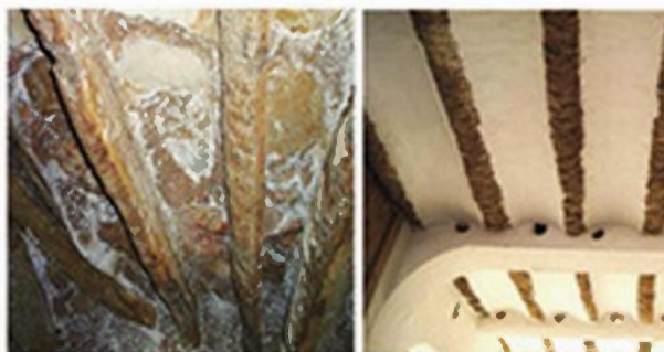
سطح من الحجارة المسطحة مستندة على عوارض خشبية من جذوع النخيل Plancher en pierres plates reposant sur des poutrelles en bois de palmiers
